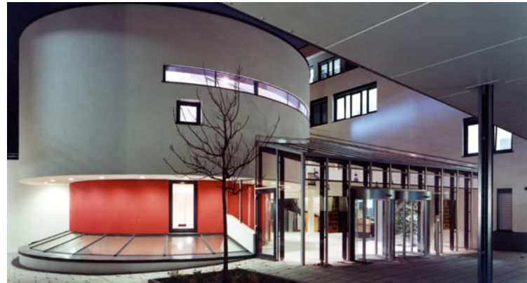
Haus der Architekten Stuttgart
