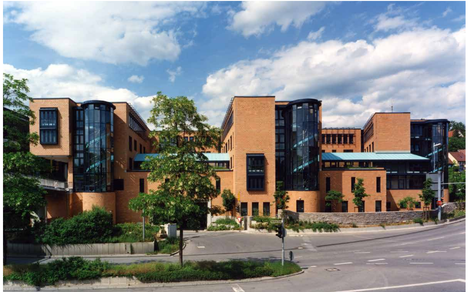
Fassade an der B10
