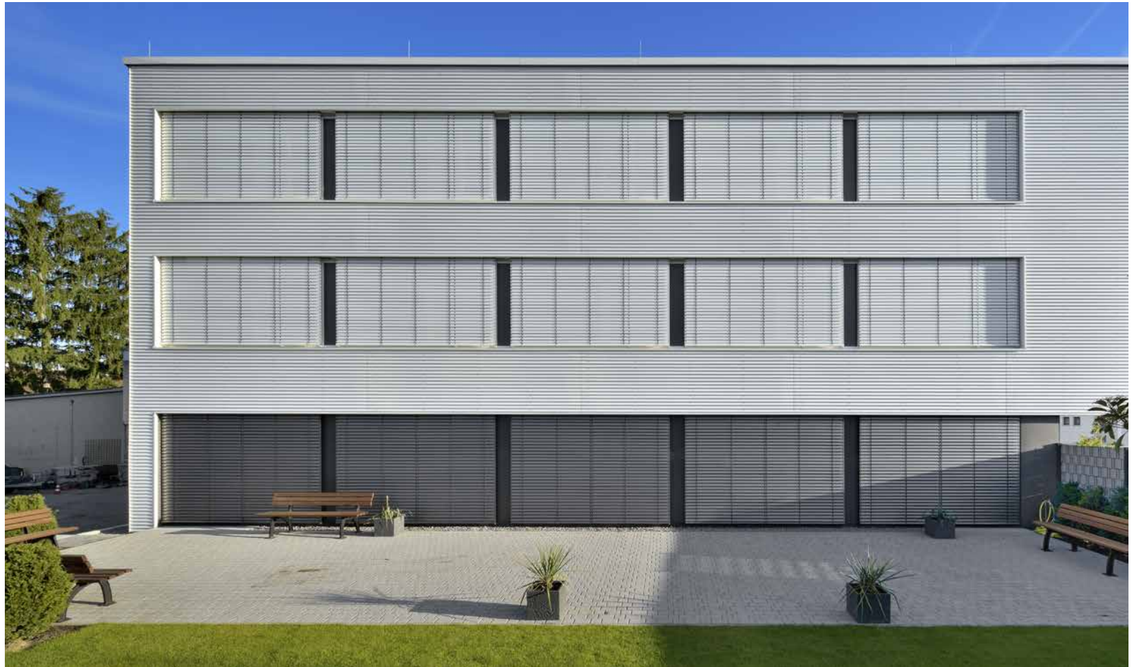
Südostfassade - Freibereich Aufenthaltsraum
